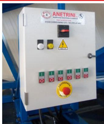
Quadro elettrico di comando con sistema controllo terra
